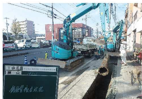
古い水道管を地震に強い水道管に取り替えているところ
