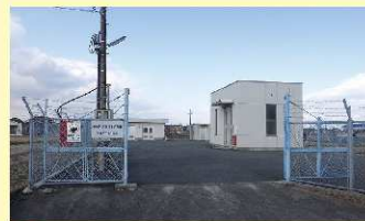
4 宮前第2水源地
