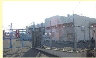
3 宮前第1水源地
